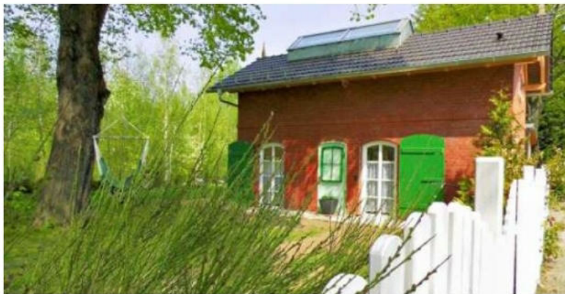
Einen alten Bahnhof – im Foto ist das anliegende Bahnhofwärterhäuschen zu sehen – haben Katrin Beikirch und Michael Schomer gekauft und restauriert.
